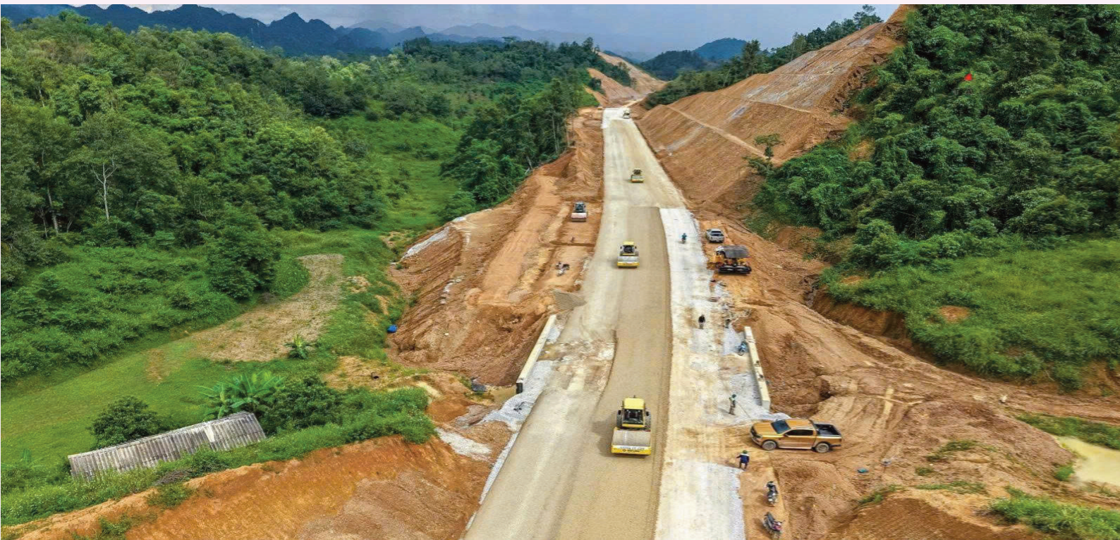
Một cung đường trên công trình đường cao tốc Bắc - Nam
